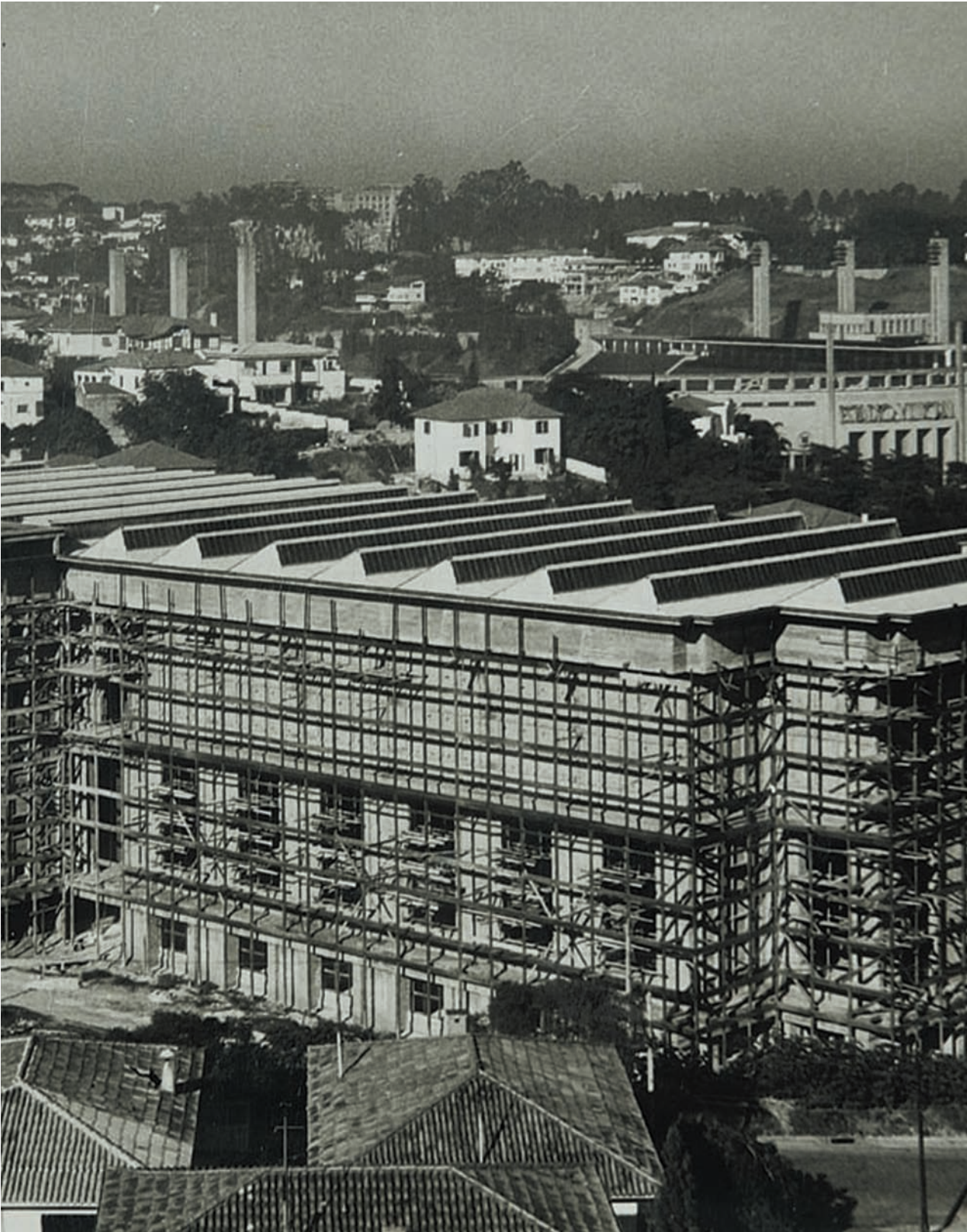
Construção da fachada da FAAP.
